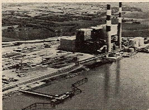
Une vue de la centrale de Cordemais... avant que ne commencent les travaux pour la réalisation des tranches 4 et 5.
