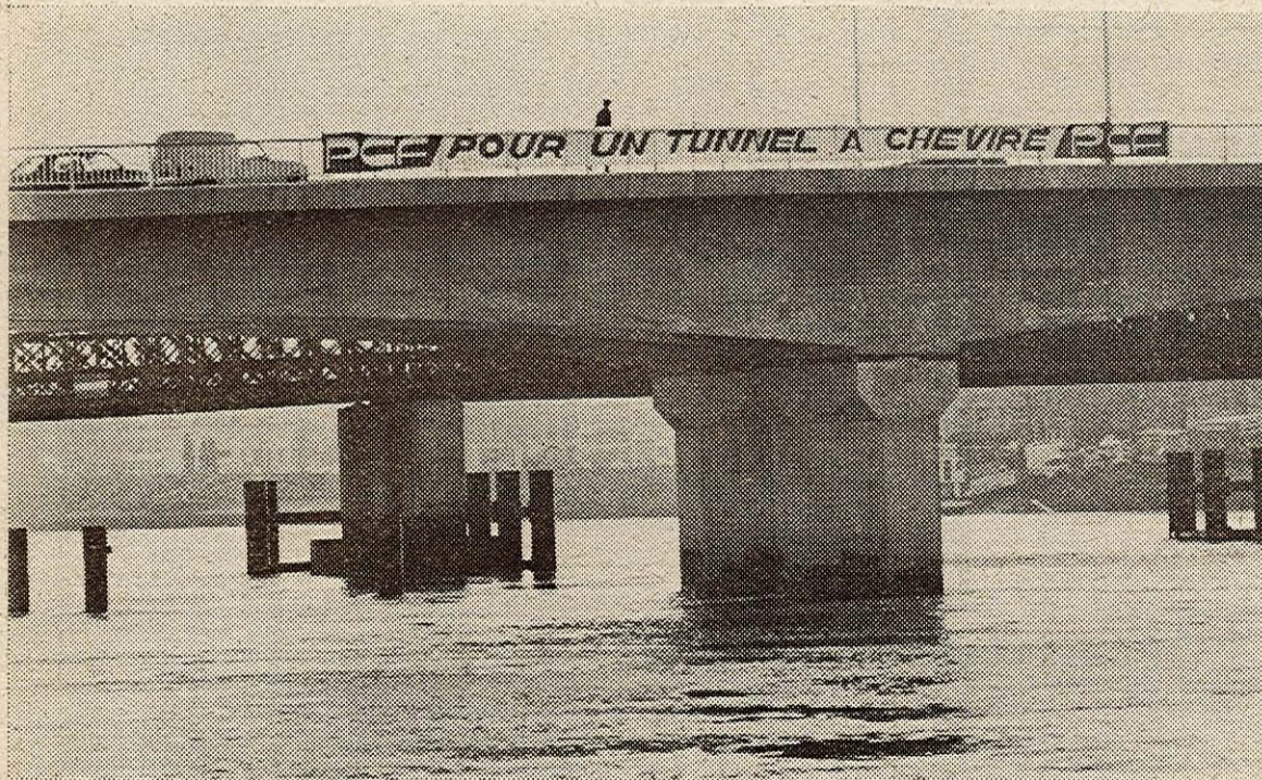
Assez de manœuvres remettant en cause les décisions des élus ! Les travaux doivent commencer et l'Etat payer sa part.
