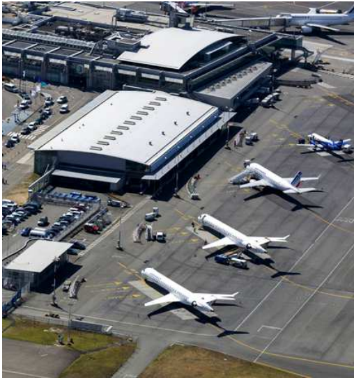
Vue de l'aéroport Nantes Atlantique
